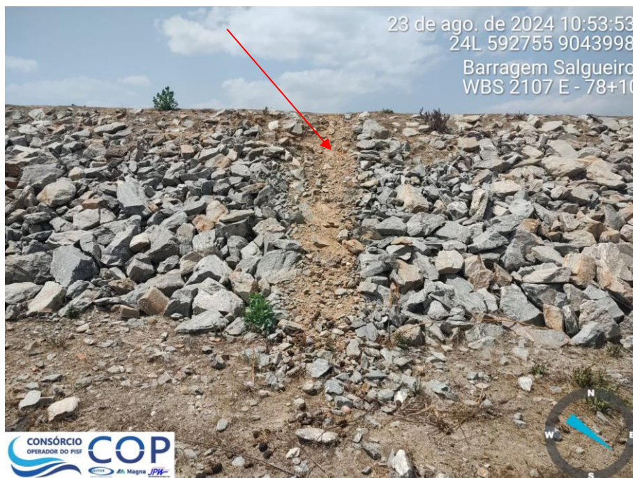
Foto 6.6: Deslocamento do material de proteção, próximo ao vertedouro na estaca 78+10, ocasionado pela passagem de motocicletas e animais.
