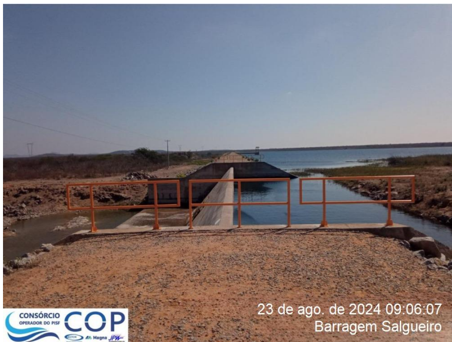
Foto 6.27: Guarda-corpos instalados sobre os muros laterais do vertedouro.
