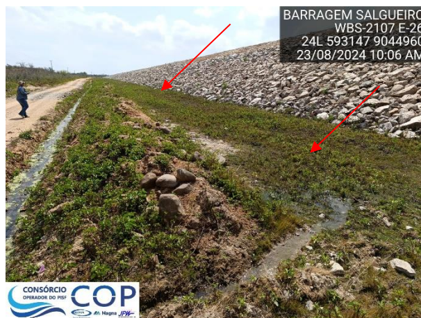
Foto 6.9: Área úmida com surgência no pé do talude e região de jusante nas proximidades da estaca 26+00.
