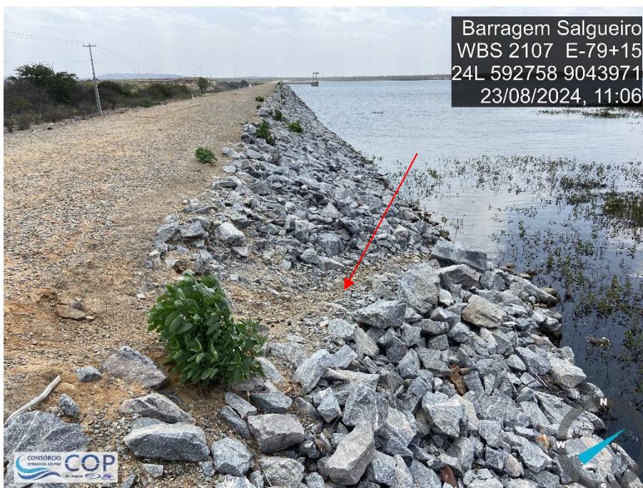
Foto 6.4: Deslocamento do material de proteção do talude de montante próximo ao vertedouro – Estaca 79+15.
