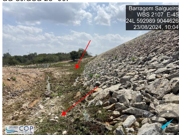
Foto 6.11: Área úmida com surgência no pé do talude e região de jusante nas proximidades da estaca 45+00.
