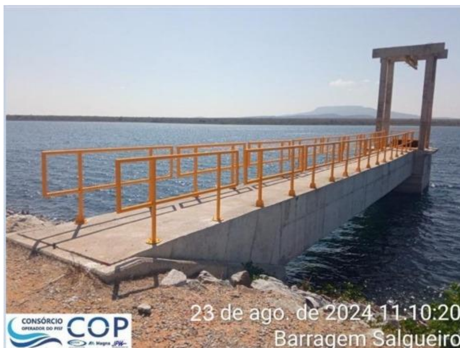
Foto 6.31: Guarda-corpo de proteção que estavam faltando instalados no acesso à torre da tomada d'água.
