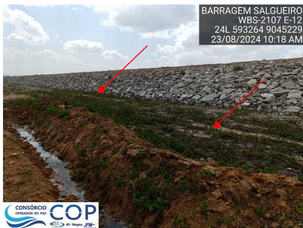
Foto 6.8: Área úmida com surgência no pé do talude e região de jusante nas proximidades da estaca 12+00.
