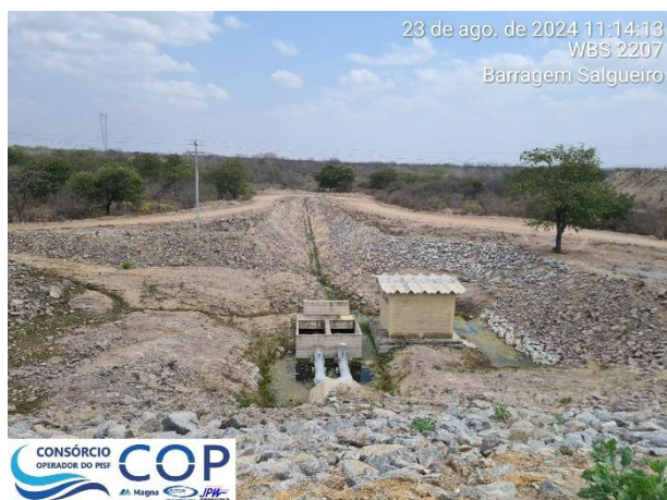
Foto 6.34: Vista da valeta executada para drenar a água proveniente do interior da galeria.
