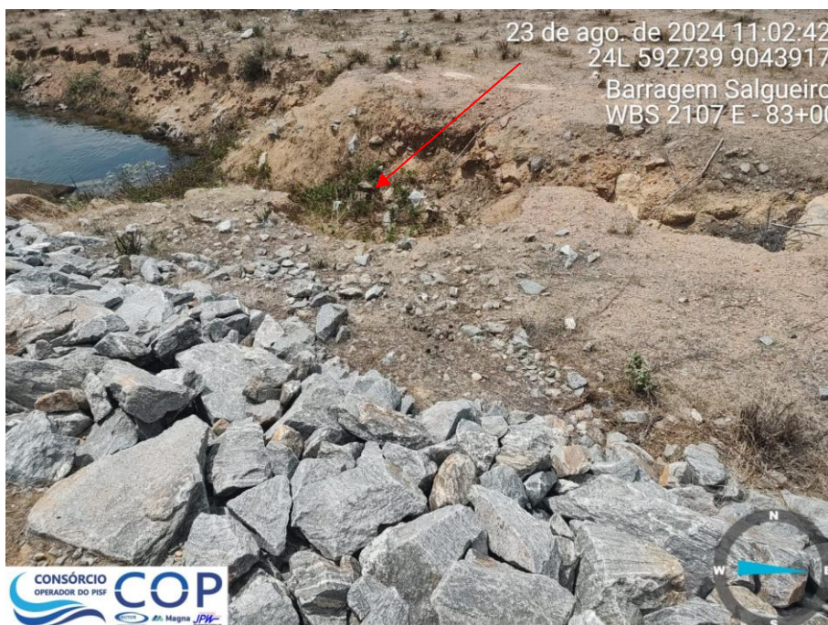
Foto 6.24: Processos erosivos próximos ao pé do talude de montante, mais precisamente na estaca 83+00.
