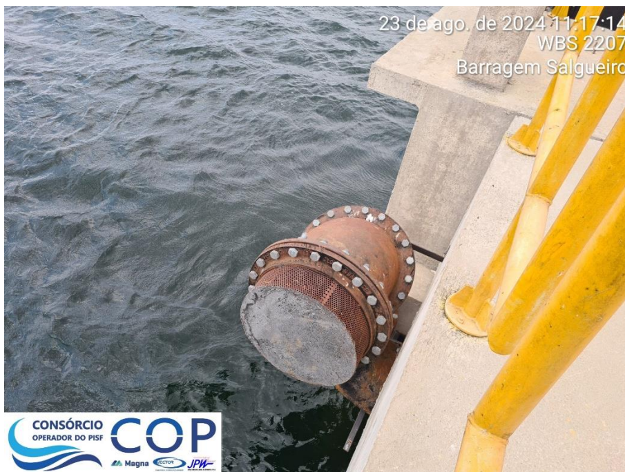
Foto 6.32: Sinais de oxidação na tubulação de aeração.
