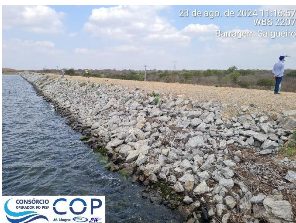
Foto 6.2: Vista do talude de montante.
