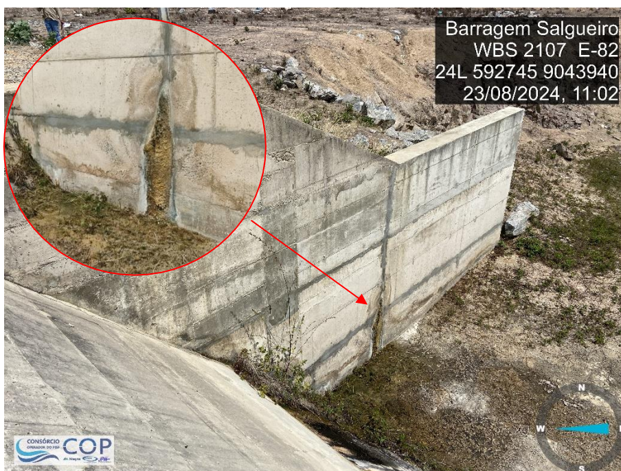
Foto 6.26: Muro lateral esquerdo apresentando trincas superficiais, mal acabamento do concreto e sinais de surgências.
