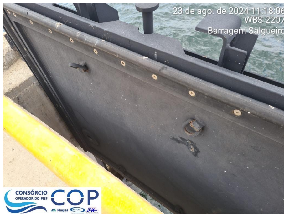
Foto 6.30: Pontos de oxidação na comporta ensecadeira e nas guias de descida da comporta/grade.
