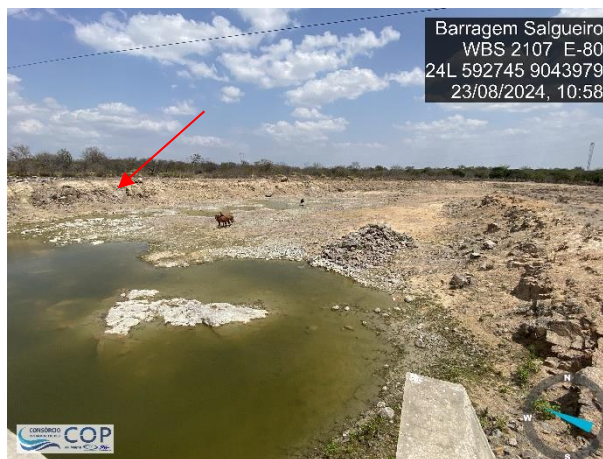
Foto 6.19: Talude natural esquerdo do canal de restituição do vertedouro apresentando processos erosivos.
