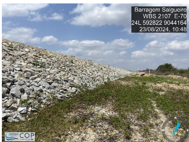
Foto 6.12: Área úmida com surgência no pé do talude e região de jusante nas proximidades da estaca 70+00.
