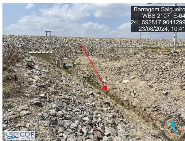
Foto 6.35: Vista da valeta executada para drenar a água proveniente do interior da galeria.
