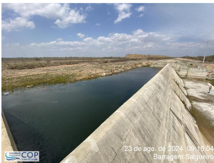
Foto 6.16: Vista do canal de aproximação do vertedouro.
