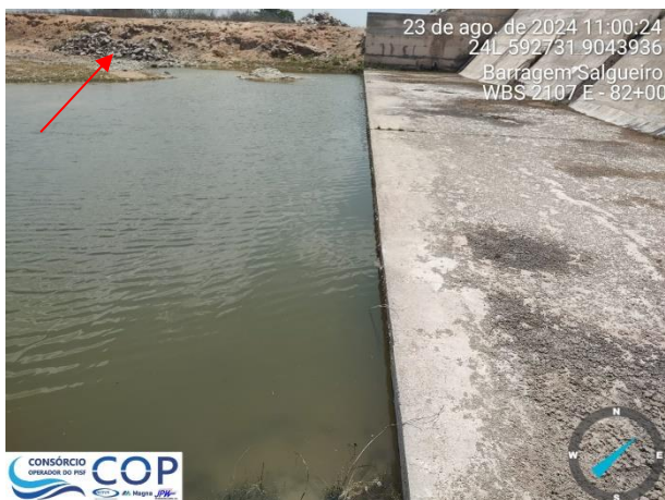
Foto 6.18: Talude natural direito do canal de restituição do vertedouro apresentando processos erosivos.
