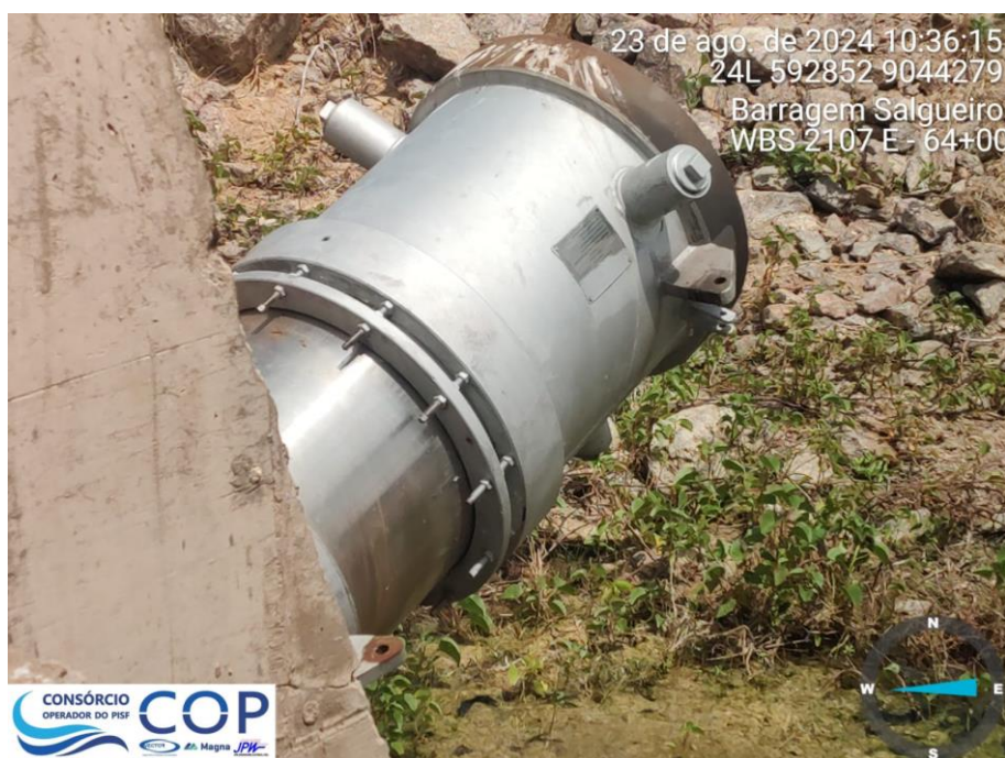
Foto 6.37: Válvula dispersora com sinais de oxidação.
