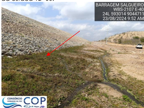
Foto 6.10: Área úmida com surgência no pé do talude e região de jusante nas proximidades da estaca 40+00.
