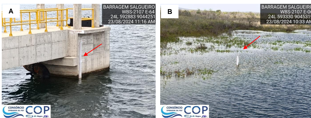
Foto 7.1: Disposição das réguas limnimétricas, instaladas na torre da tomada d'água (A) e na área do reservatório, nas proximidades da ombreira direita (B).
