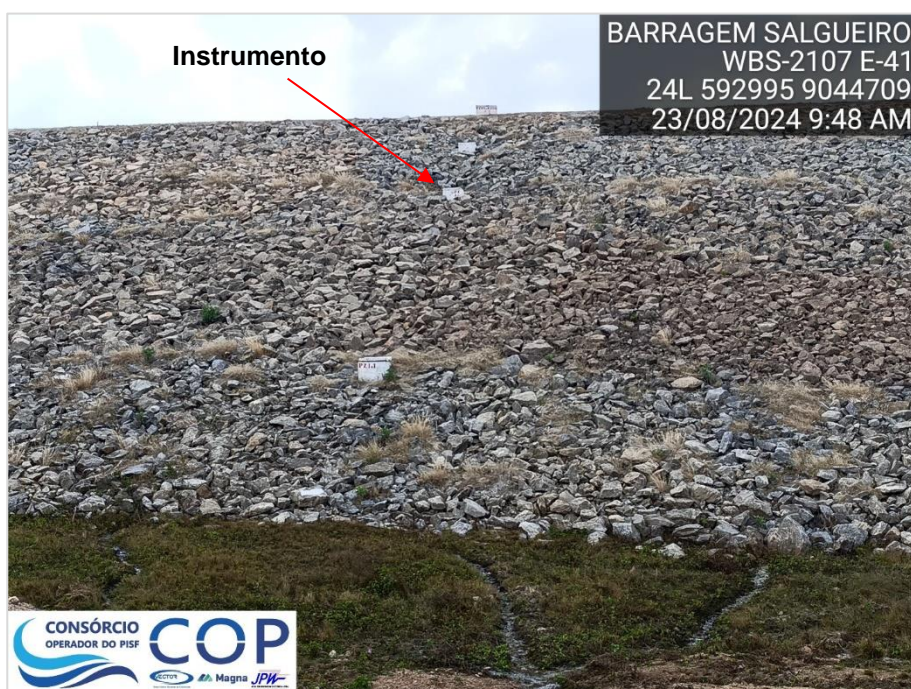
Foto 6.15: Falta de estrutura de acesso aos instrumentos na barragem, no talude de jusante, estaca 41+00.
