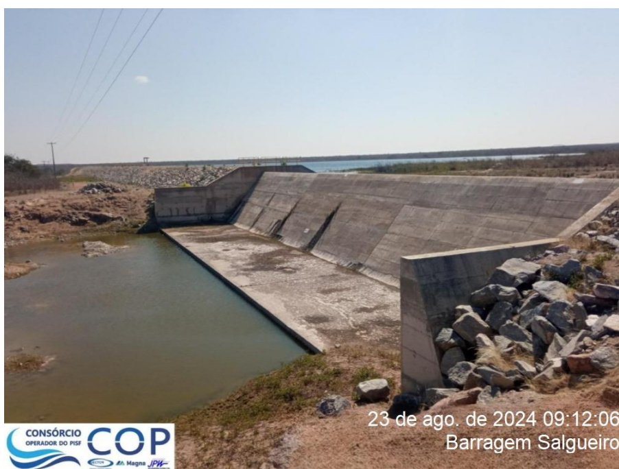
Foto 6.20: Vista da estrutura do vertedouro, apresentando pequenas fissuras e mal acabamento do concreto.
