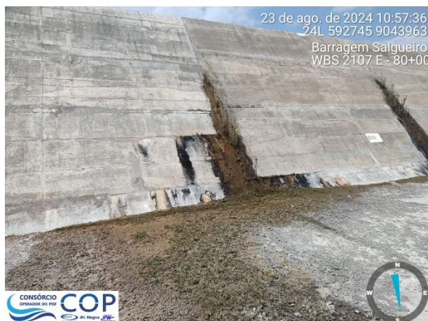
Foto 6.21: Vazamentos pelas juntas na estrutura do vertedouro.
