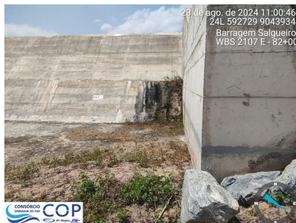
Foto 6.22: Vazamentos pelas juntas na estrutura do vertedouro.
