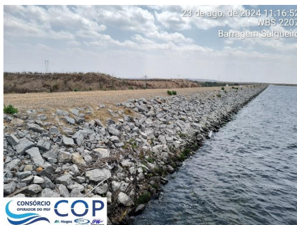
Foto 6.3: Vista do talude de montante.
