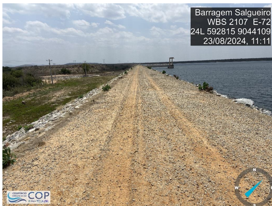
Foto 6.5: Vista do coroamento da barragem, apresentando sinais de tráfego de veículos.
