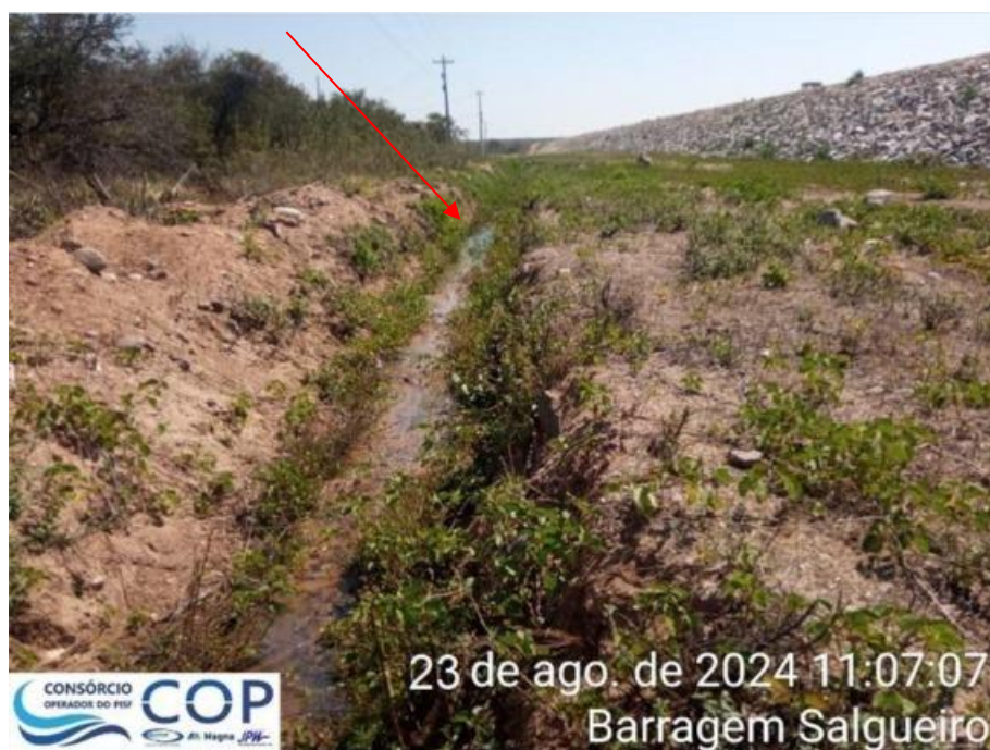
Foto 6.14: Vala executada entre as estacas 71+00 a 73+00.
